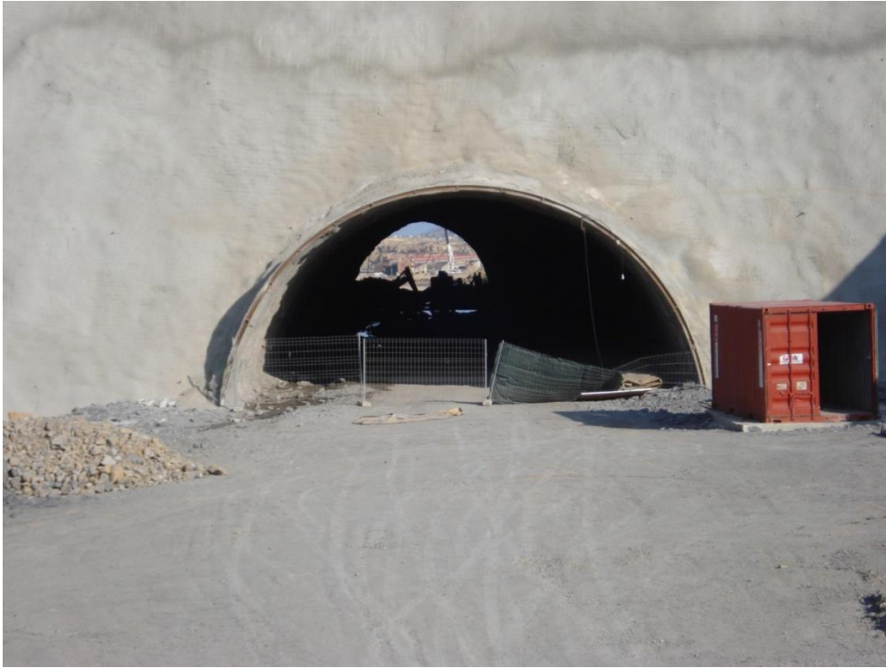
Foto: Imagen del túnel calado en sección de avance
