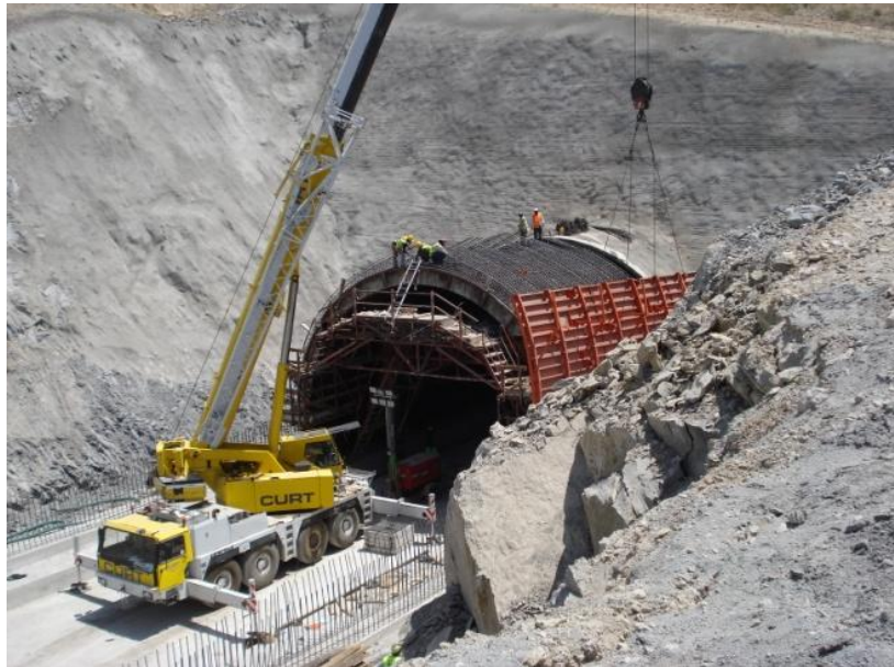
Foto: Operaciones de ferrallado y encofrado en bóveda túnel artificial
