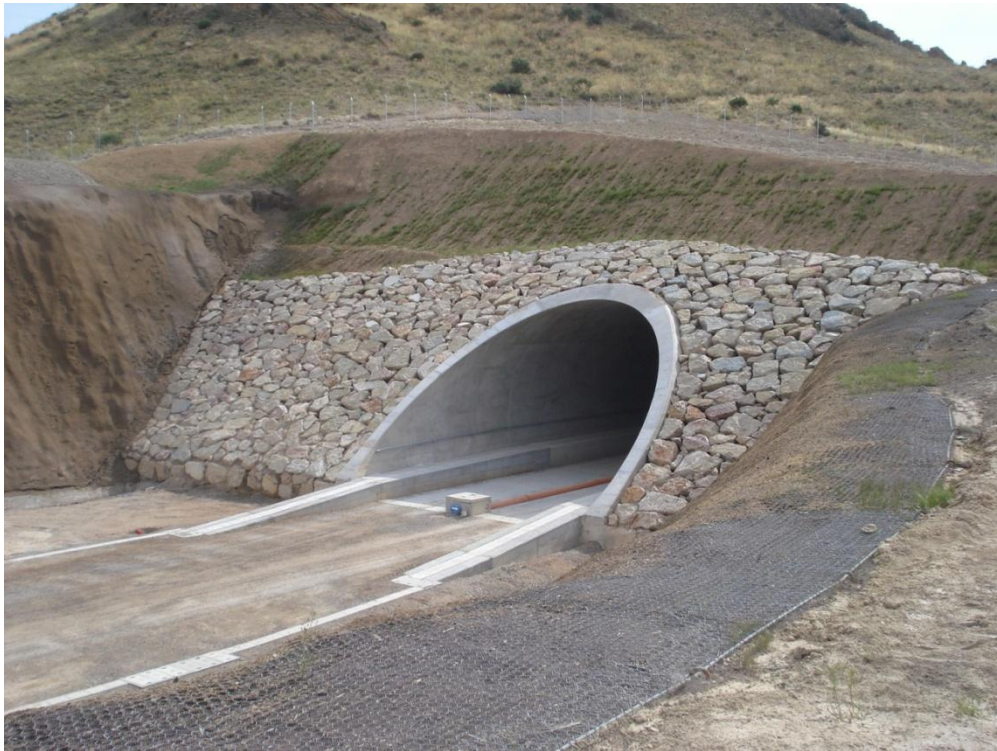
Foto: Vista general del emboquille TA PK- restaurado integralmente
