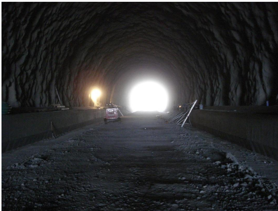
Foto: Imagen del túnel con las aceras finalizadas en ambos lados
