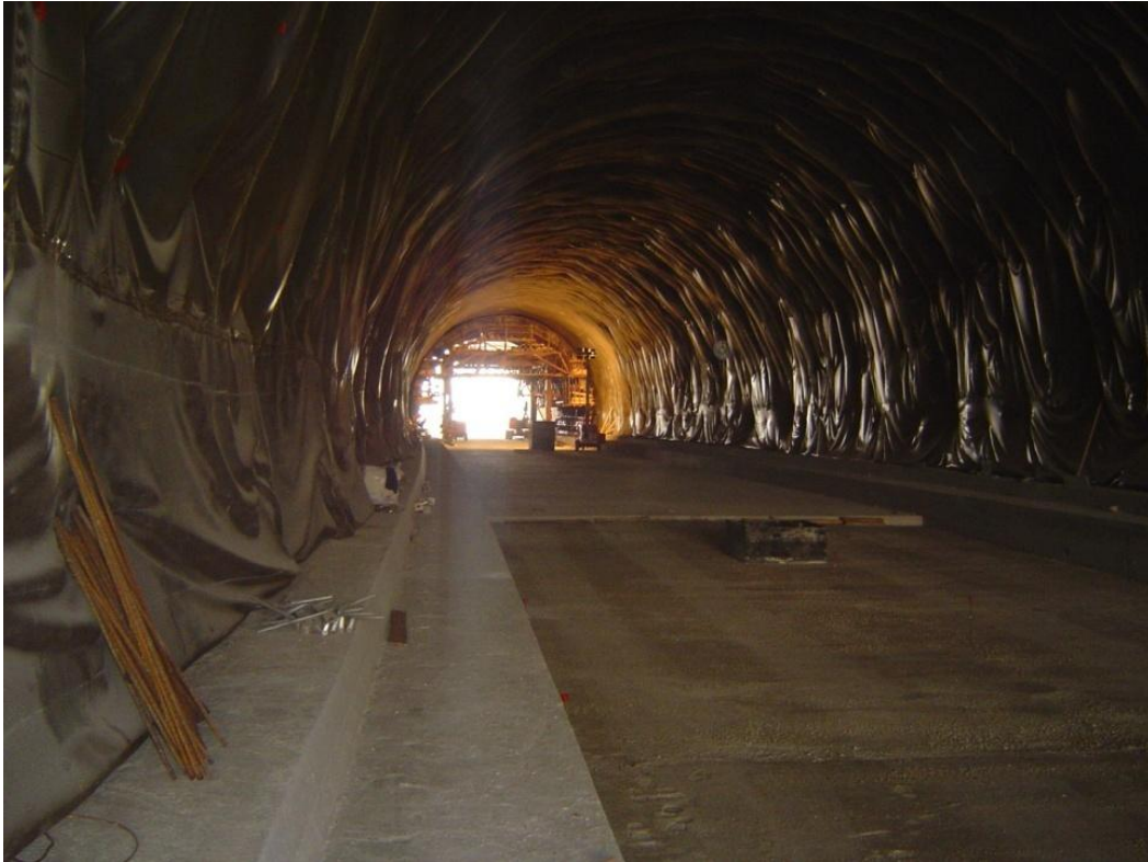
Foto: Imagen del túnel impermeabilizado en toda su superficie
