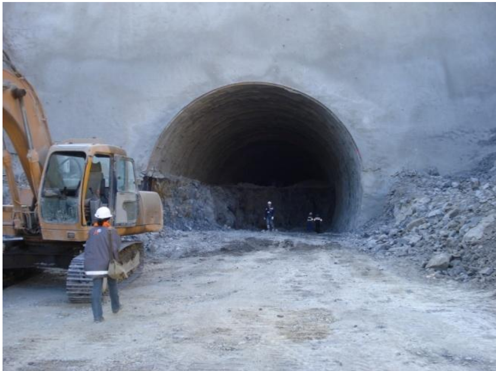
Foto: Imagen del túnel calado en sección de destroza
