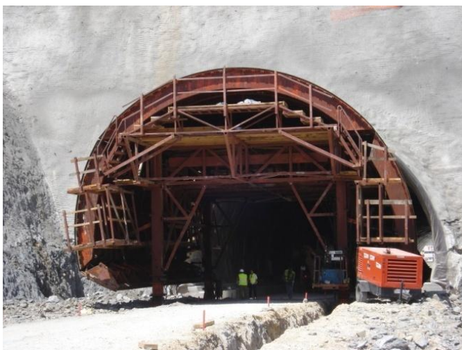
Foto: Carro de encofrado
