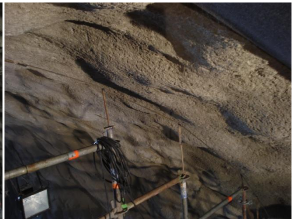
Detalle de perfil instalado en el carro pasando bajo el sostenimiento durante la comprobación
