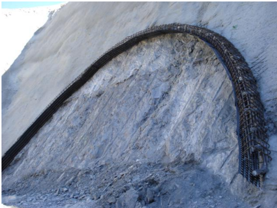
Foto: Armadura en viga de atado de paraguas de micropilotes
