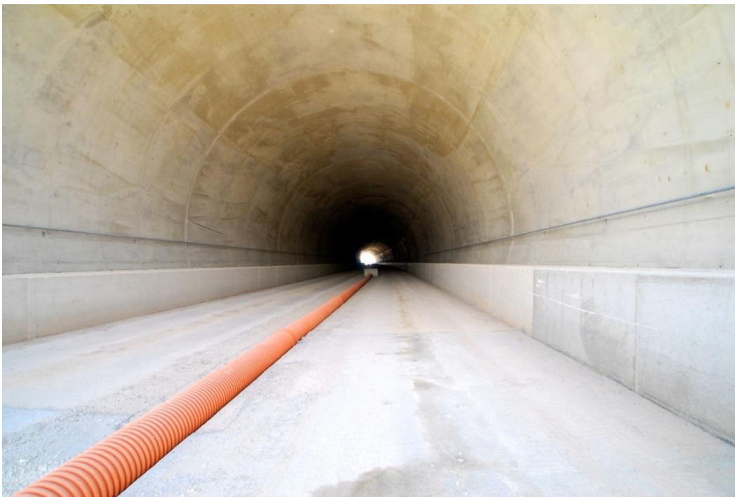
Foto: Imagen de la sección de túnel en mina finalizada
