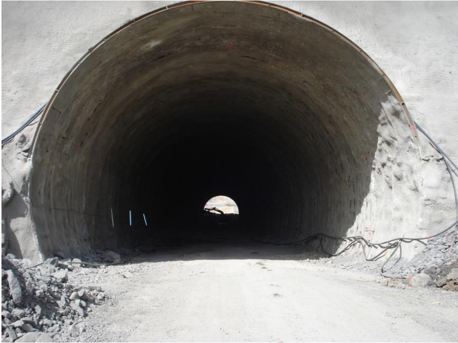
Foto: Imagen del túnel finalizada la excavación y sostenimiento de la destroza
