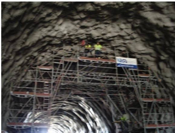
Carro situado bajo sostenimiento comprobando las secciones de manera continua
