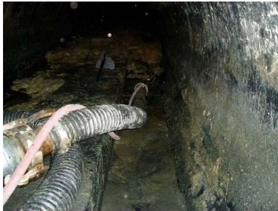
Trabajos de bombeo y limpieza de residuos
