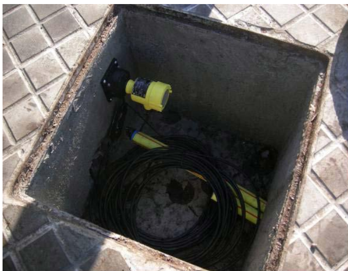
Detalle de arqueta i registro del limnómetro de presión en la salida del sifón de Marina
