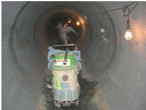
Impermeabilización de juntas en tubo.
