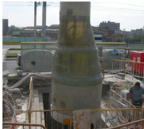
Instalación pozo de entrada de personal de PRFV
