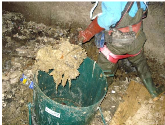
Trabajos de limpieza manual de residuos sólidos sedimentados
