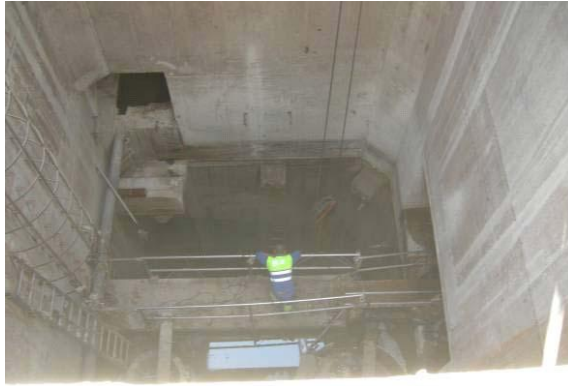
Acondicionamiento de la cámara de entrada
