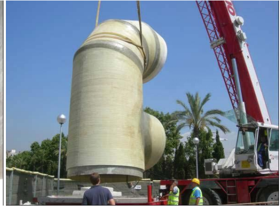
Instalación tubería D2000 PRFV
