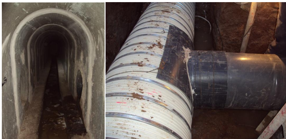
Conexión de aguas negras a la alcantarilla
