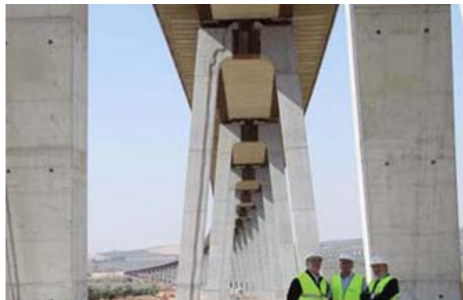
Vista interna de los vanos y del tablero
