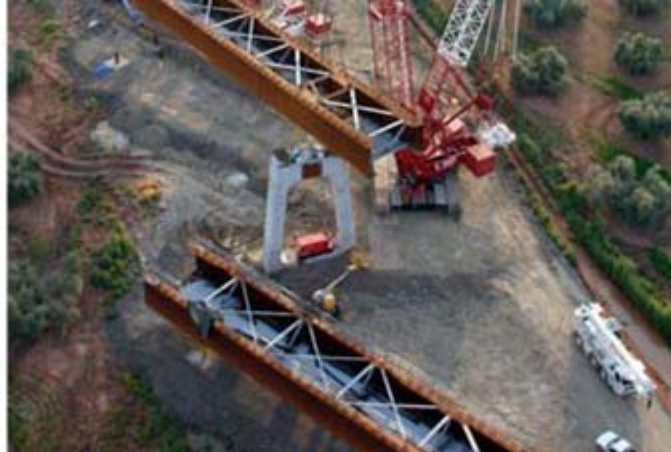
Vista aérea del proceso de construcción de los vanos
