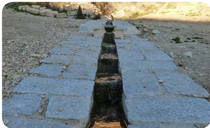
Nueva canalización en el Caño del Obispo
