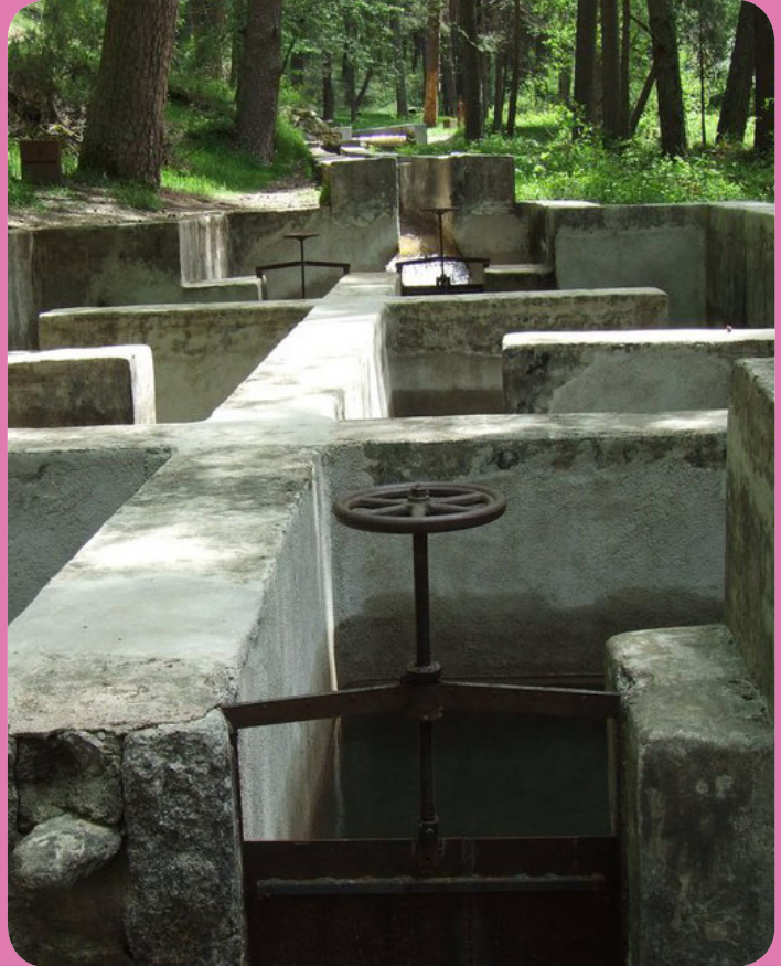
Captación funcionando tras su recuperación
