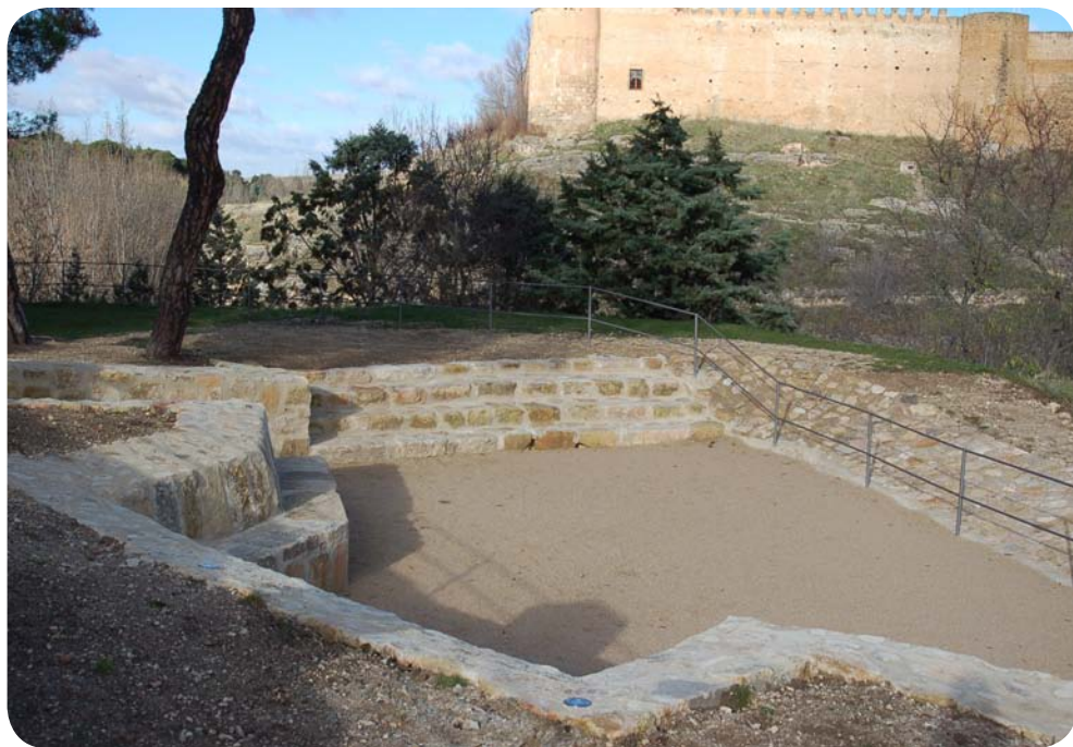
Estado final del Mirador
