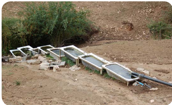
Estado original del Caño del Obispo en la Cacera de Regantes
