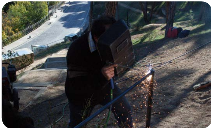
Trabajos en las vallas de protección de las tumbas
