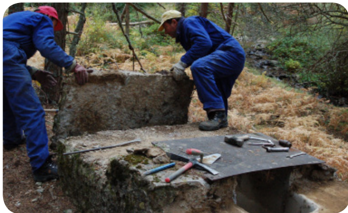
Trabajos de recupera- ción de los arquetones
