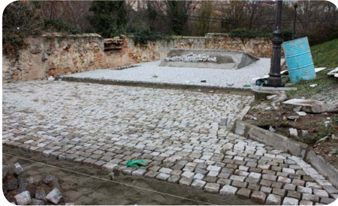
Fase de adoquinado de la plaza anexa al Cavila
