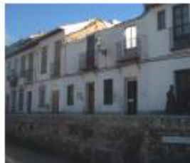
Rehabilitación de fachada en C/ Carril de la Loma
