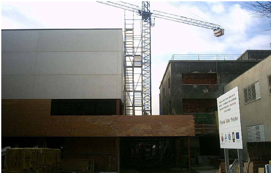
Escuela-taller Polydor. Avance de las obras.
