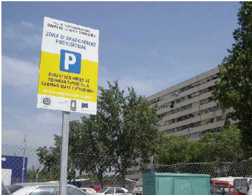
Reurbanización de calles (Mar y Marte) Señalización obras y aparcamiento provisional.
