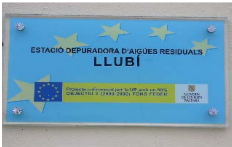
Il·lustració 7. Placa commemorativa de la estació depuradora de aigües residuals de Llubí
