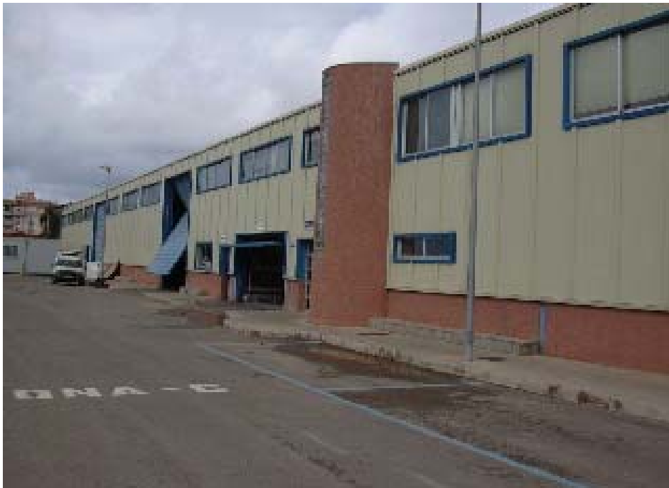
Ilustración 17. Nuevas oficinas de los Servicios Ferroviarios de Mallorca
