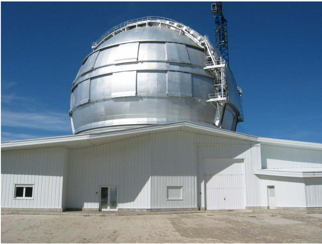
Proyecto GTCA00-26-01 (GRANTECAN) Fuente: Visita control DGI-MEC 11 de noviembre de 2004
