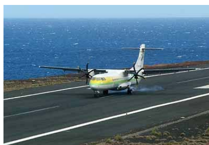
Aeropuerto del Hierro. Nivelación franja pista
