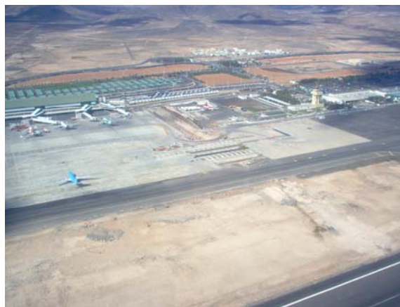
Estacionamiento de aeronaves. Nuevo edificio terminal
