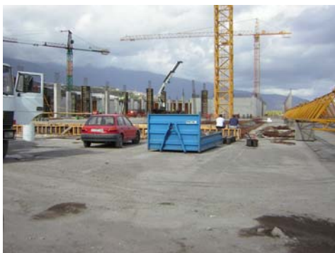
Obras del Nueva Área Terminal y Torre
