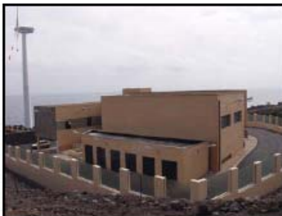
Nueva Central Eléctrica Aeropuerto de la Palma.
