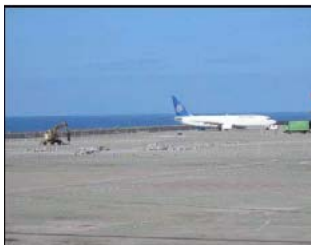
Reparación losas Plataforma. Aeropuerto de Tenerife Sur.
