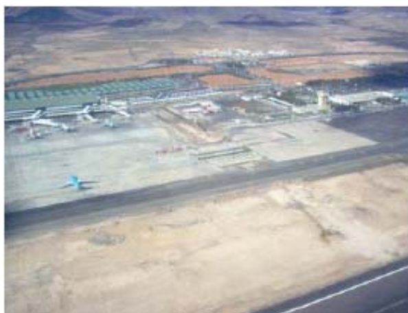
Estacionamiento de aeronaves. Nuevo edificio terminal
