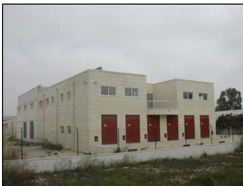
Subcentral Eléctrica. Aeropuerto de Alicante
