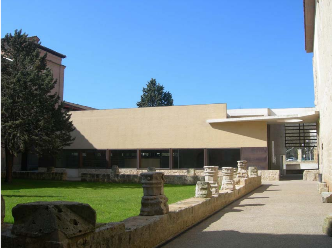
FOTOS 11 (1 Y 2). JAVIER BLANCO. RESTOS DEL CLAUSTRO Y NUEVO PABELLÓN QUE SE APOYA SOBRE EL MURO DE LA ANTIGUA BIBLIOTECA, LOS HUECOS EN NÚMERO Y TAMAÑO HACEN REFERENCIA A LA COMPOSICIÓN DEL CLAUSTRO.
