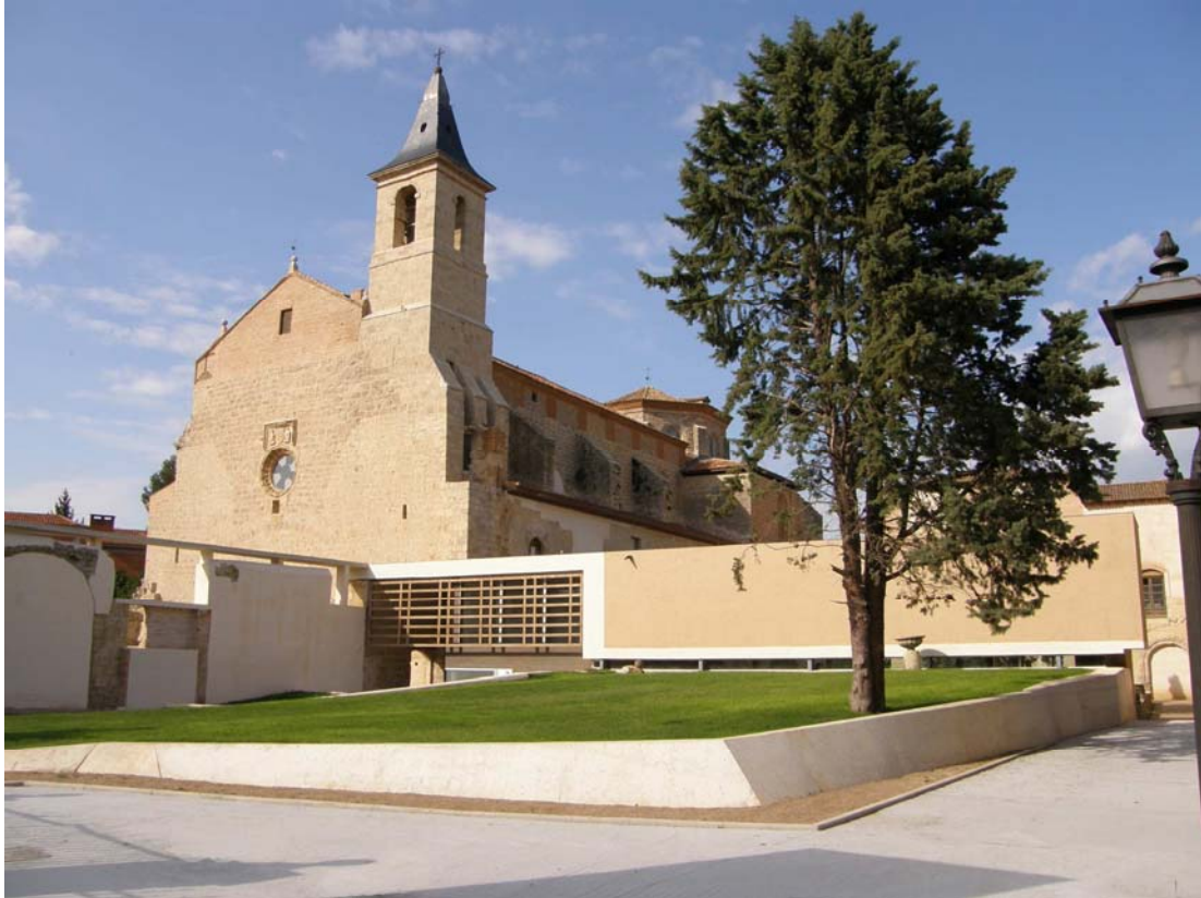
FOTO 12. VISTA EXTERIOR DEL CONJUNTO CONVENTUAL, CON LA IGLESIA AL FONDO SOBRE EL NUEVO PABELLÓN.
