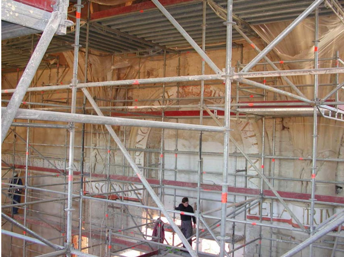
FOTO 3. JAVIER BLANCO. RESTAURACIÓN DE PARAMENTOS INTERIORES DE LA IGLESIA Y SUS CAPILLAS, CON RECUPERACIÓN DE REVOCOS Y PINTURAS MURALES, PREVIO PICADO DE JUNTAS Y REINTEGRACIÓN DE ELEMENTOS PÉTREOS Y YESERÍAS.
