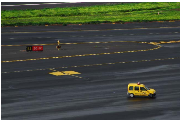
Adecuación pista. Tenerife Norte
