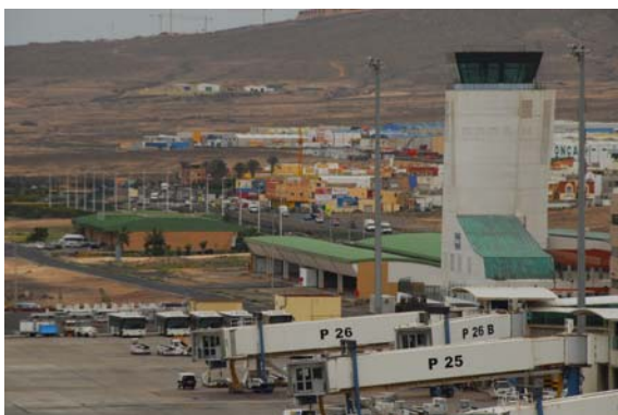
Nueva Torre de Control. Fuerteventura
