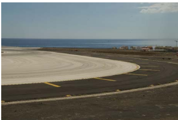
Ampliación apartadero de espera. Tenerife Sur
