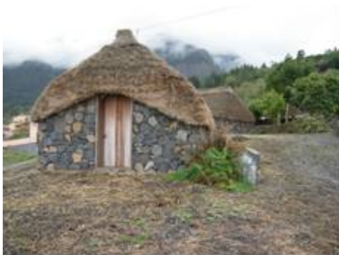
Rehabilitación edificios tradicionales (La Orotava)
