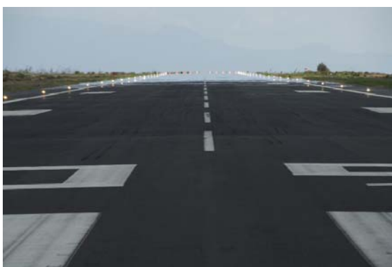
Regeneración superficial de pista. La Gomera
