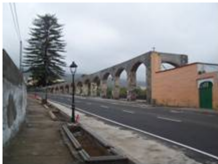
Acueducto de Argüal
