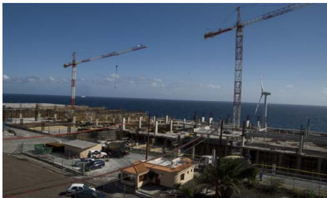
Nueva Área Terminal y Torre de Control
