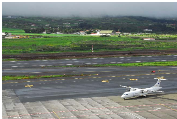
Ampliación plataforma lado este. Tenerife Norte
