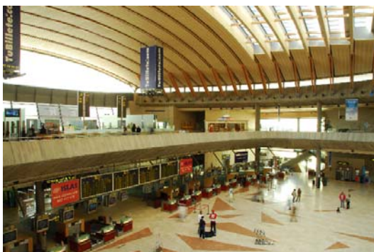
Edificio Terminal para vuelos interinsulares. Tenerife Norte
