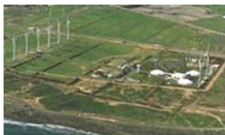
Instituto Tecnológico de Canarias. Sede Pozo Izquierdo (Gran Canaria)
