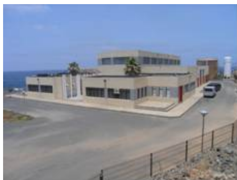
Desaladora de Arucas-Moya
