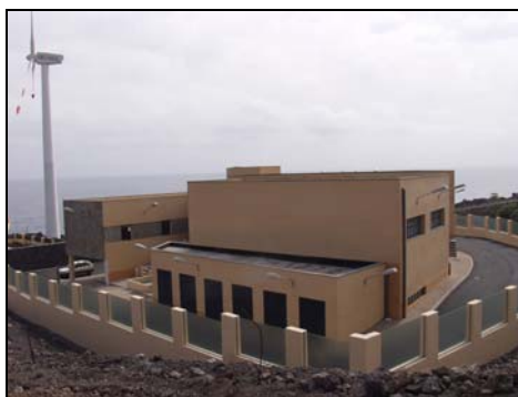
Nueva Central Eléctrica Aeropuerto de la Palma.
