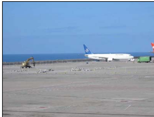
Reparación losas Plataforma. Aeropuerto de Tenerife Sur.
