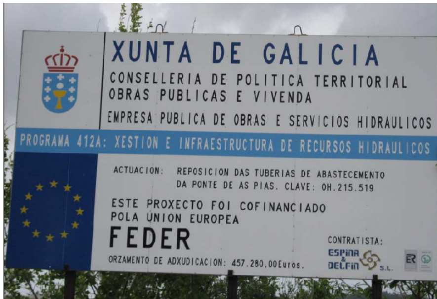
Valla informativa de las obras de reposición de las tuberías de abastecimiento en el Puente de las Pías, en el ayuntamiento de Fene.
