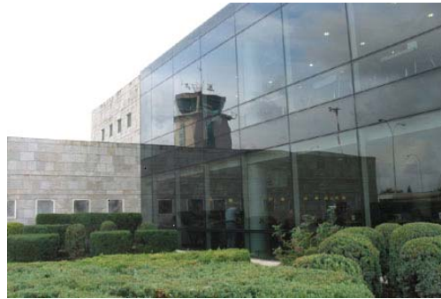
Edificio Terminal. A Coruña
