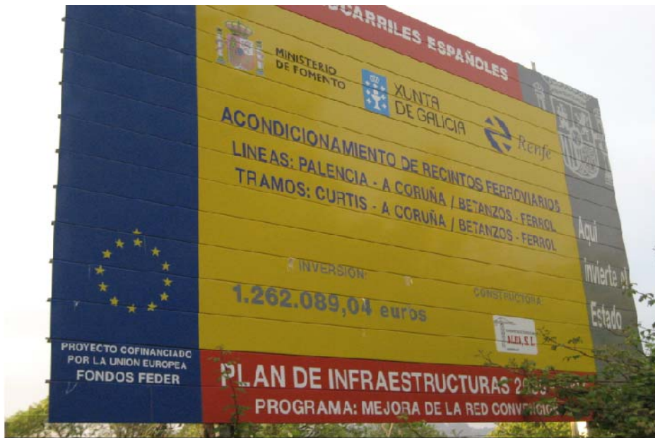
Labores de acondicionamiento ferroviario realizadas durante el año 2006 en la línea Curtis-A Coruña, con la participación conjunta de la Xunta de Galicia, el Ministerio de Fomento y el FEDER.
