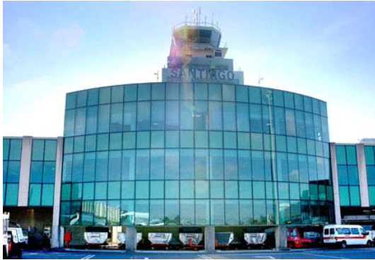
Nueva torre y Centro de Control. Santiago
