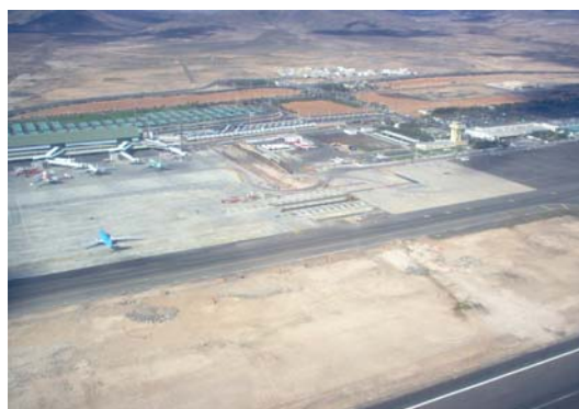
Estacionamiento de aeronaves. Nuevo edificio terminal
