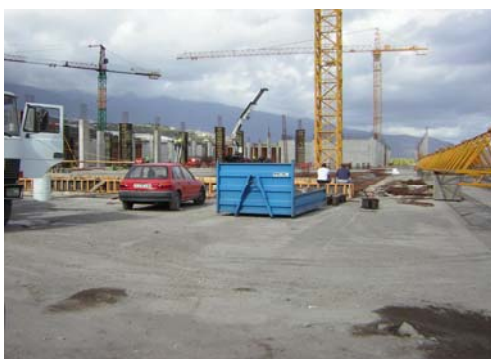
Obras del Nueva Área Terminal y Torre
