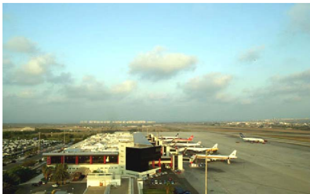
Plataforma estacionamiento. Alicante
