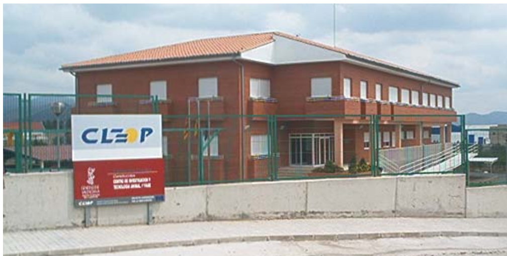
Fachada principal del Centro de Investigación Técnica Animal de Segorbe
