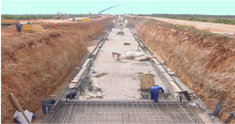
Ferrallado de soleras.
