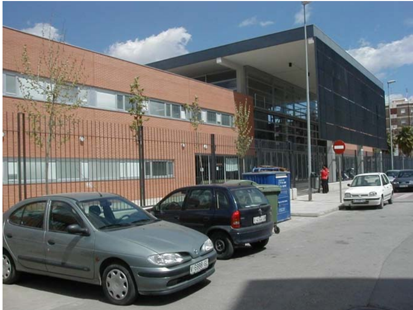
Fachada principal del Instituto de Tabernes Blanques.
