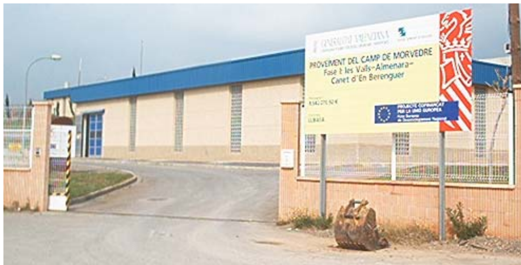
Acceso a la Estación Potabilizadora de Aguas de Sagunto.
