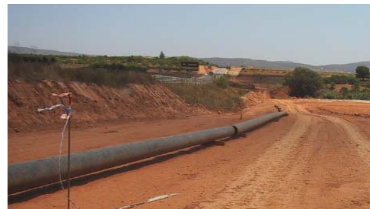
Colocación de tuberías durante la fase de ejecución.
