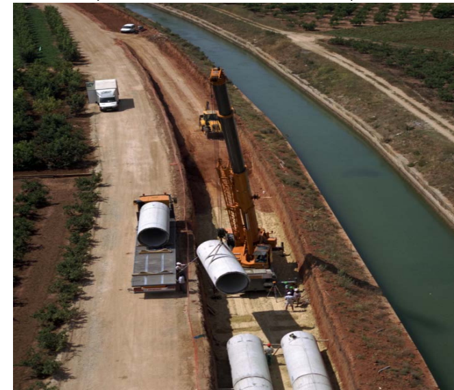
Colocación de tubos en la zanja paralela a la Acequia Real del Júcar.
