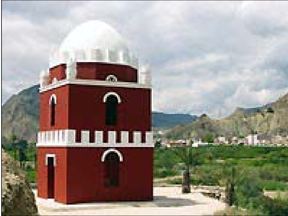
Ilustración 11. Estado final del edificio Gurugú de Ulea
