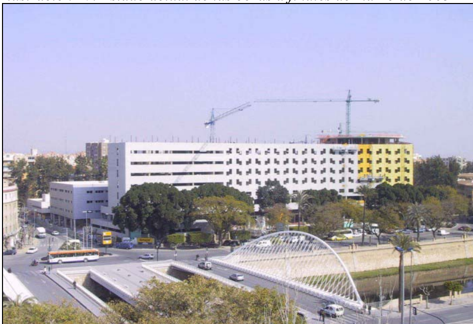
Ilustración 17. Estado actual de las obras a finales de marzo de 2003
