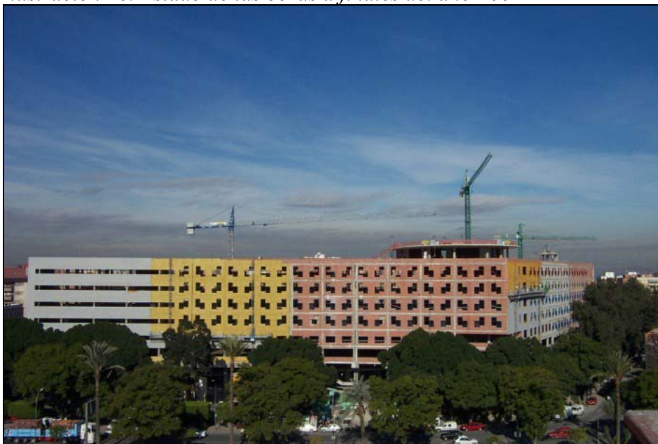
Ilustración 16. Estado de las obras a finales del año 2002
