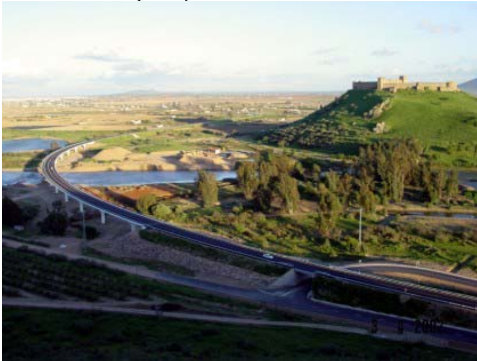
Ilustración 5. Nuevo puente y variante de Medellín
