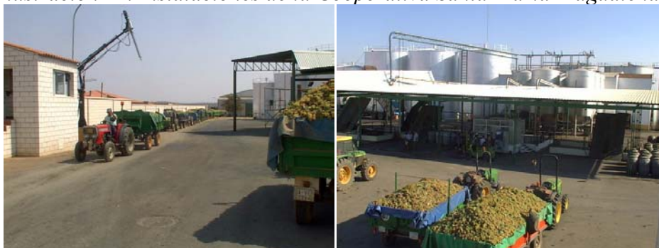
Ilustración 11. Instalaciones de la Cooperativa Santa María Magdalena
