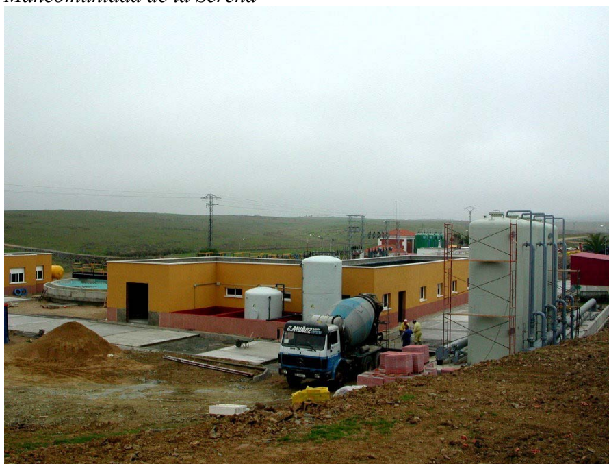
Ilustración 8. Construcción de la nueva ETAP y Conducción – Mancomunidad de la Serena
