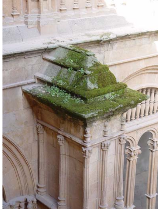
Vista previa a la intervención
