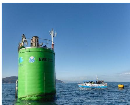
Fabricación e instalación en el mar del primer dispositivo de tecnología vasca para la generación de energía de las olas.
