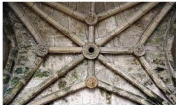
Detalles del techo de la Capilla
