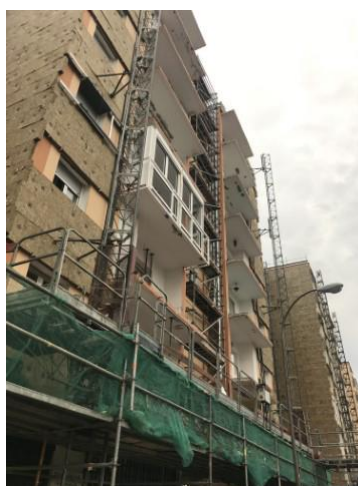
Rehabilitación energética del edificio C/ Azoz, 5
