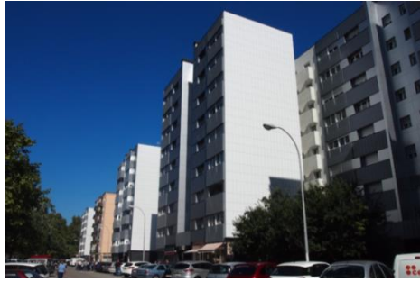
Calle Azoz después de la rehabilitación
