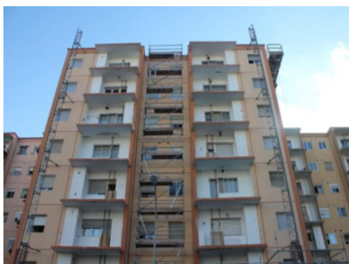
Rehabilitación energética del edificio C/ Azoz, 5
