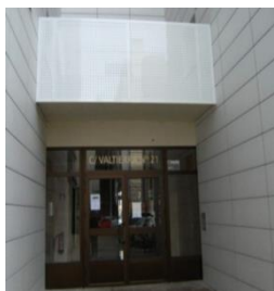
Edificio C/ Valtierra, 21 con placa permanente
