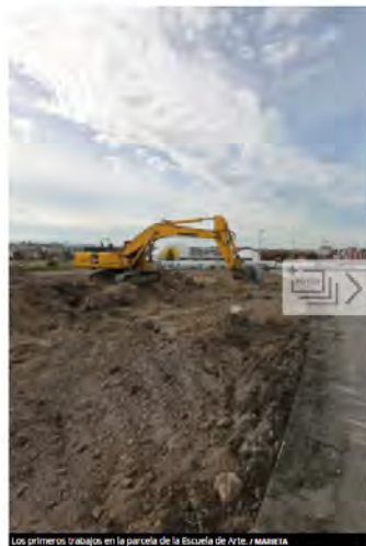
Los primeros trabajos en la parcela de la Escuela de Arte. / MARBETA
