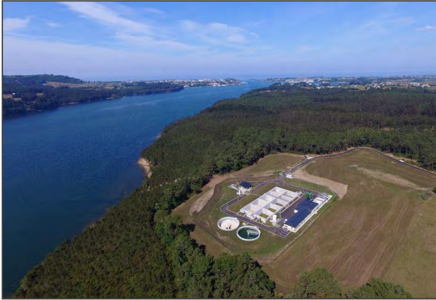
Vista aérea de las instalaciones de depuración
