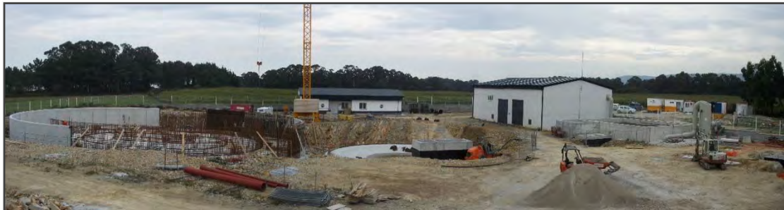
Panorámica, durante la ejecución, del reactor biológico y la decantación secundaria
