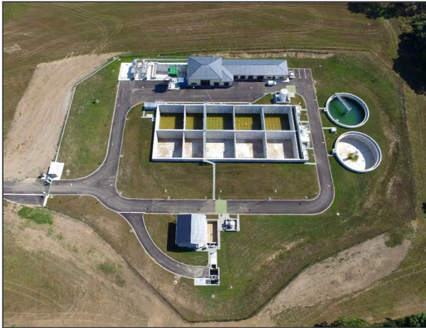
Vista aérea de las dos líneas de tratamiento
