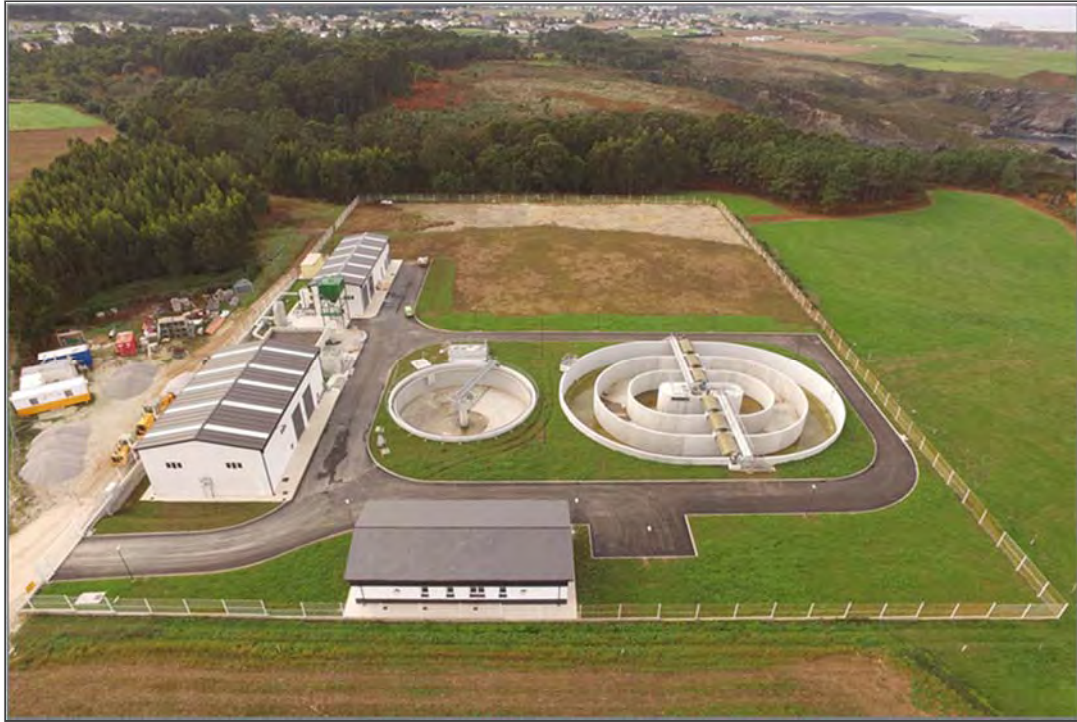
Vista aérea de las instalaciones de depuración
