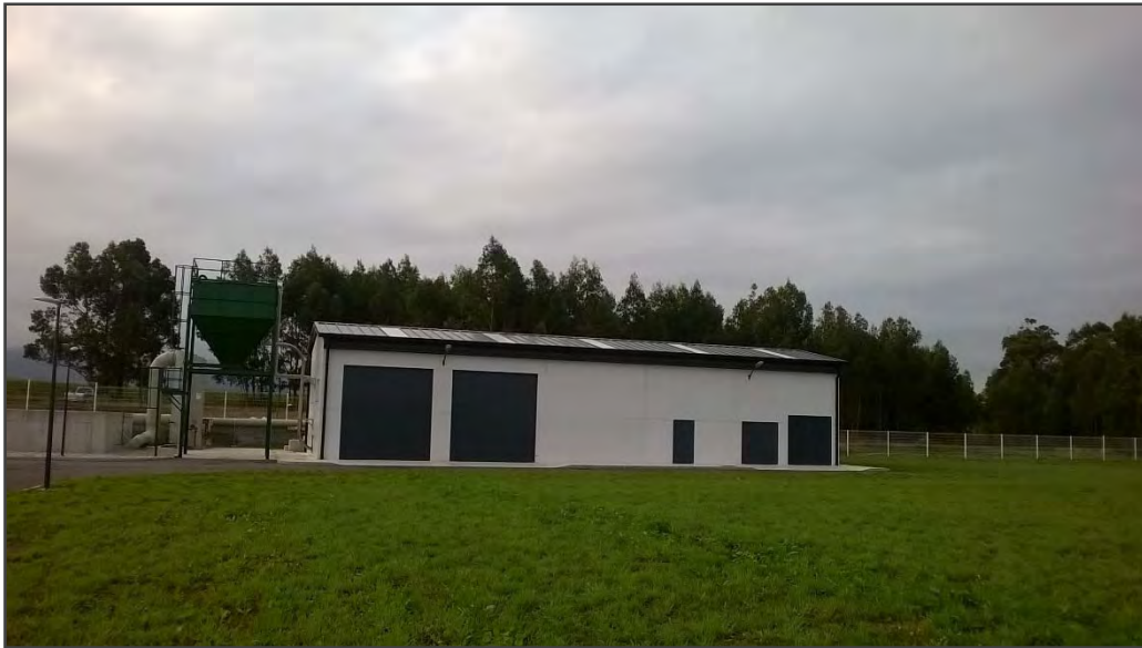
Vista frontal del edificio tratamiento de fangos
