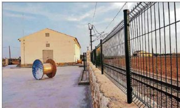
Imagen de la nueva subestación de tracción construida en sa Pobla. WTR
