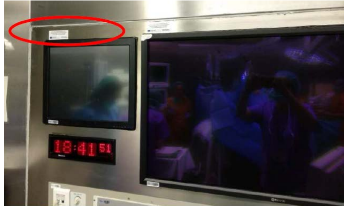
Pantalla de projecció en la Sala de telemedicina de Cardiologia Pediàtrica
