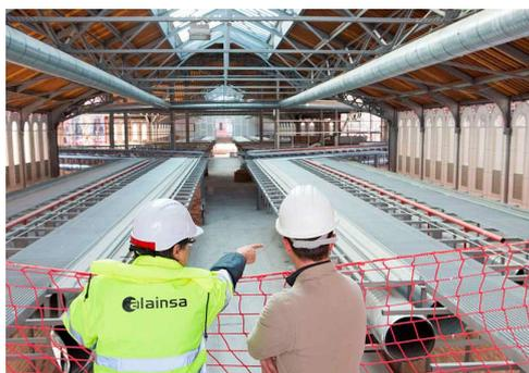
*Trabajos realizados por Alamo Industrial en el nuevo Mercado de San Antonio, en las instalaciones de electricidad, alumbrado, telecomunicaciones, megafonía, detección y extinción de incendios, climatización, geotermia, calefacción y ventilación, fontanería y urbanización exterior.*
