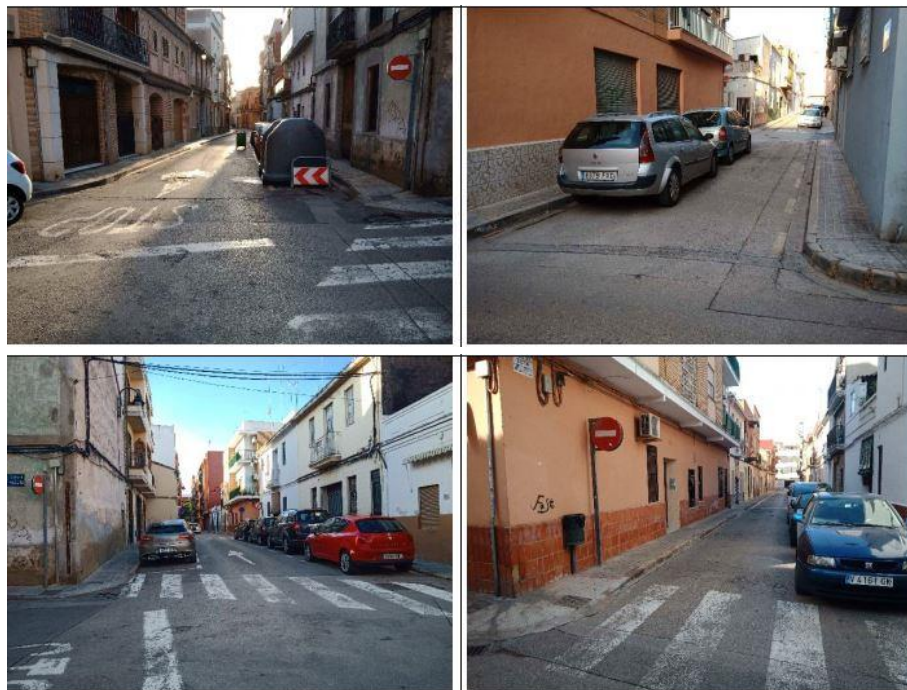
LAS CALLES PRESENTABAN UN ASPECTO MUY DETERIORADO Y DEFICIENCIAS URBANÍSTICAS
