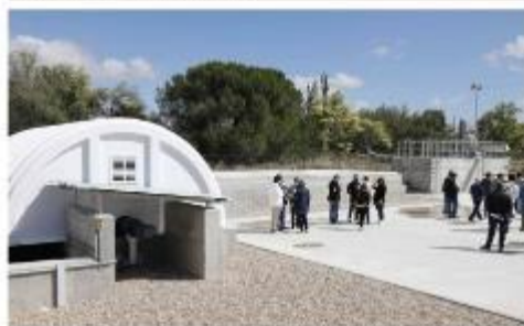
Instalaciones de la estación de la depuradora de Quintanilla de Onésimo, durante la inauguración.
