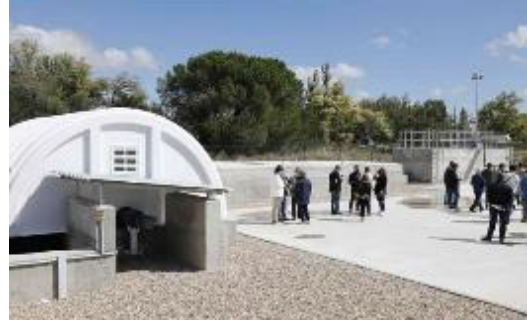
Image 2.- Quintanilla de Onésimo Wastewater Treatment Plant.
