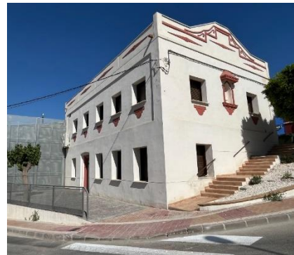
Fachada Este reformada
