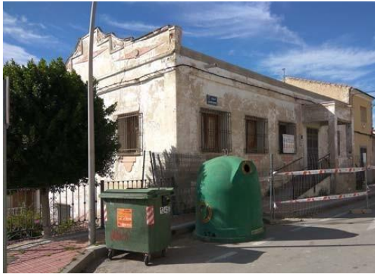
Antes, Fachada Norte
