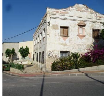
Antes, Fachada Este
