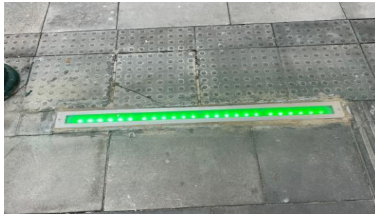
Led situados en la plataforma peatonal para señalar los cruces y los pasos de peatones
