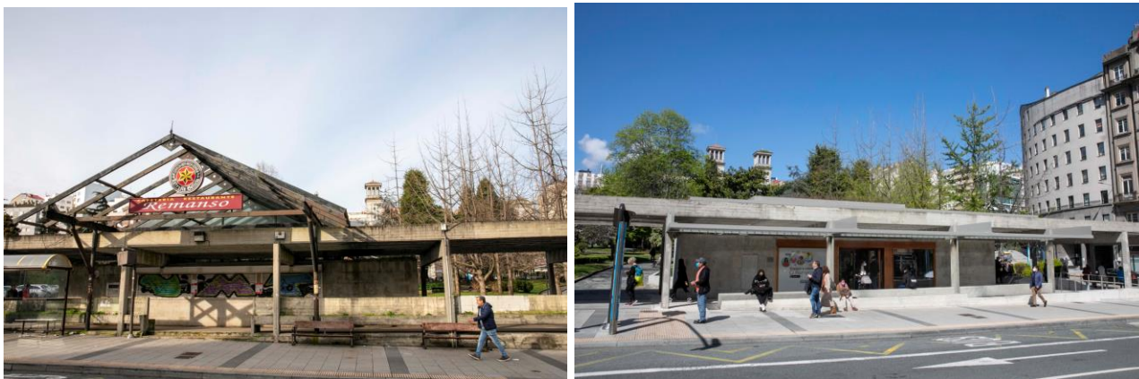
IMAGEN DEL EDIFICIO ANTES Y DESPUÉS DE LA REFORMA
