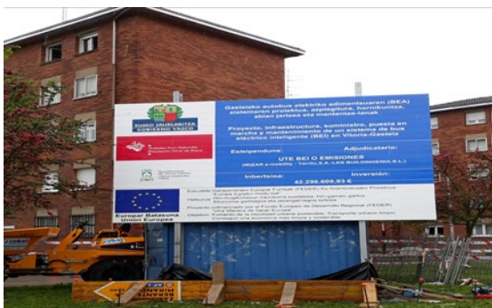
Cartelería provisional durante la obra
