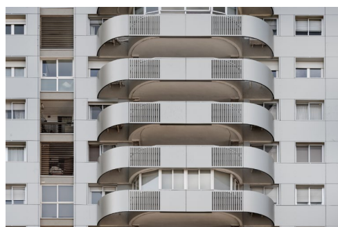
Imagen obra ejecutada. Foto IDAE
