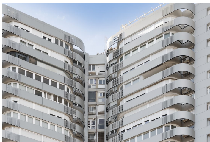
Nueva fachada del edificio con integración de la unidad exterior del aparato de aire acondicionado. Foto IDAE
