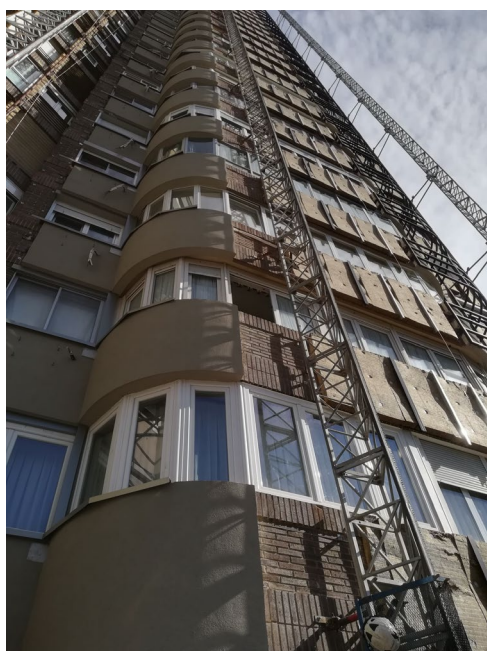
Renovación de fachada. Foto cortesía Estudio de Arquitectura De Lapuerta+Campo
