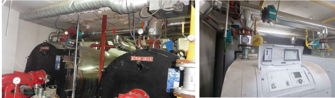
Renovación de la sala de calderas.
