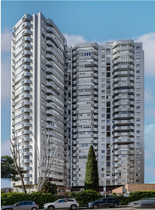
Edificio Condado de Treviño, 2 después de la rehabilitación. Fuente IDAE
