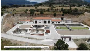
Estación depuradora de aguas residuales en la Comarca Agraria de Hervás
