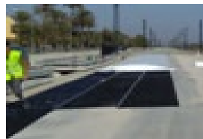
Colocación de manta elastomérica en la estación de San Isidro
