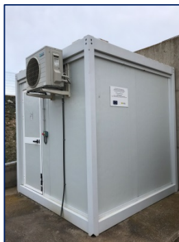
Placa permanente planta de Navarra
