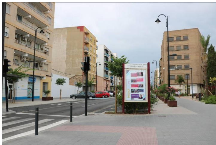
IMAGEN DE LA ACTUACIÓN COMPLETADA
