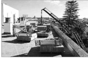
Trabajos de la descarga del material ayer en el geriátrico.
