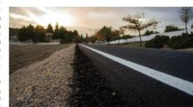
En la renovación del firme se usó polvo de neumático
