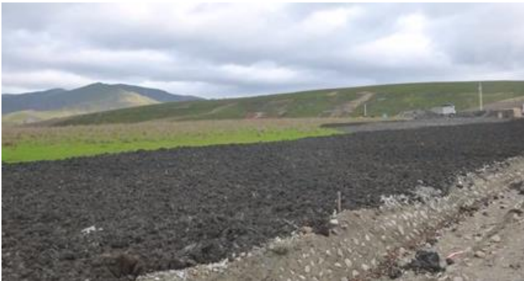
Utilización de tecnosoles en materiales extraídos del túnel del Espiño
