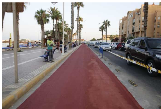
Construcción del carril bici
