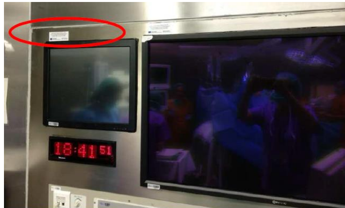
Panel en el quirófano con el sistema integrado
