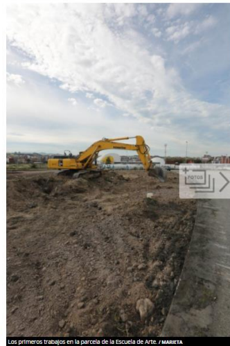
Los primeros trabajos en la parcela de la Escuela de Arte. / MARIETA
