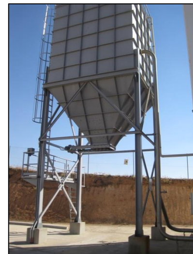
Tolva almacenamiento fangos
