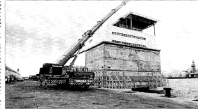
Plan preliminar en 2007. Sobre esta base, luego de la construcción de un sistema de apoyo, el 28 de agosto de 2010 se inició el montaje de la estructura de control de la plataforma de cultivo marino.
