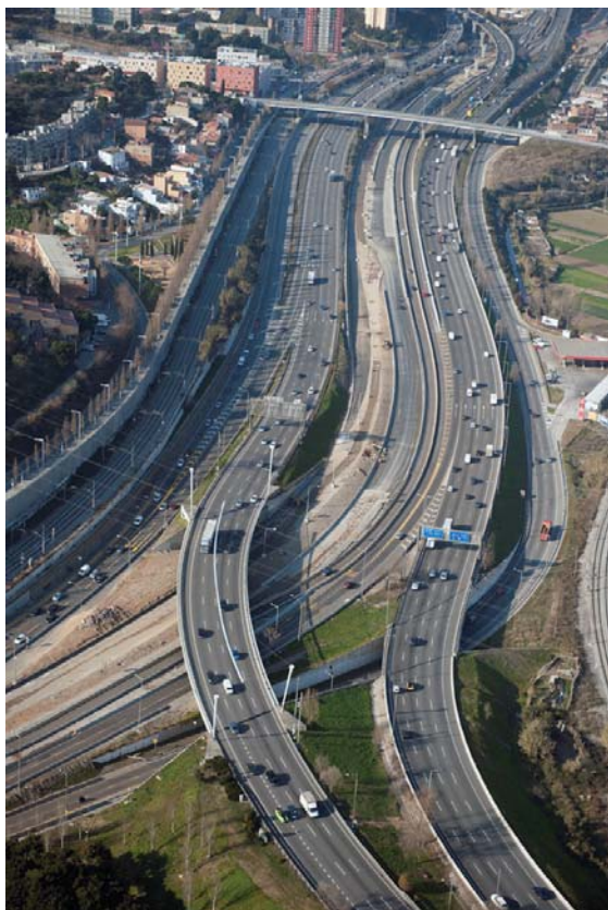
Foto 7: formación de las nuevas calzadas del carril bus vao y de la autopista C-33
