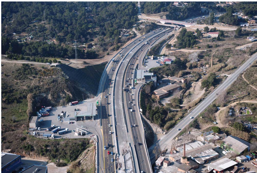
Foto 4: formación del carril bus-vao en el centro de la calzada de la autopista C-58
