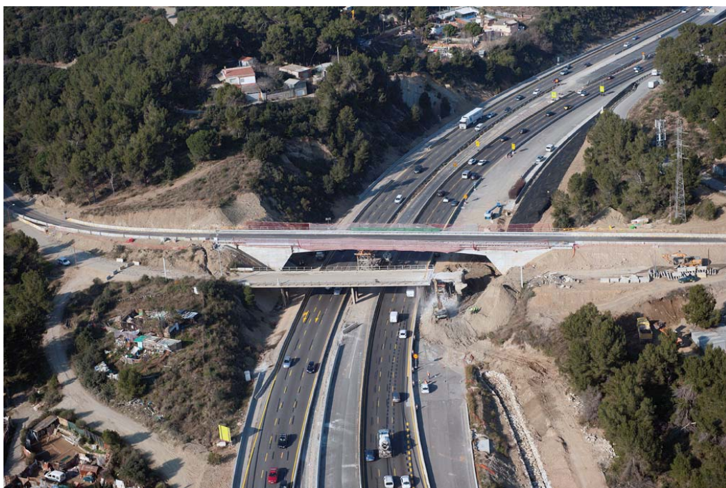
Foto 3: Nuevo puente del cementerio y antiguo puente en proceso de derribo.
