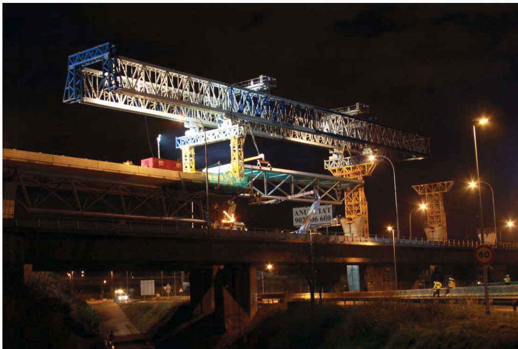
Foto 6: montaje nocturno del vano 4 mediante el lanza vigas.
