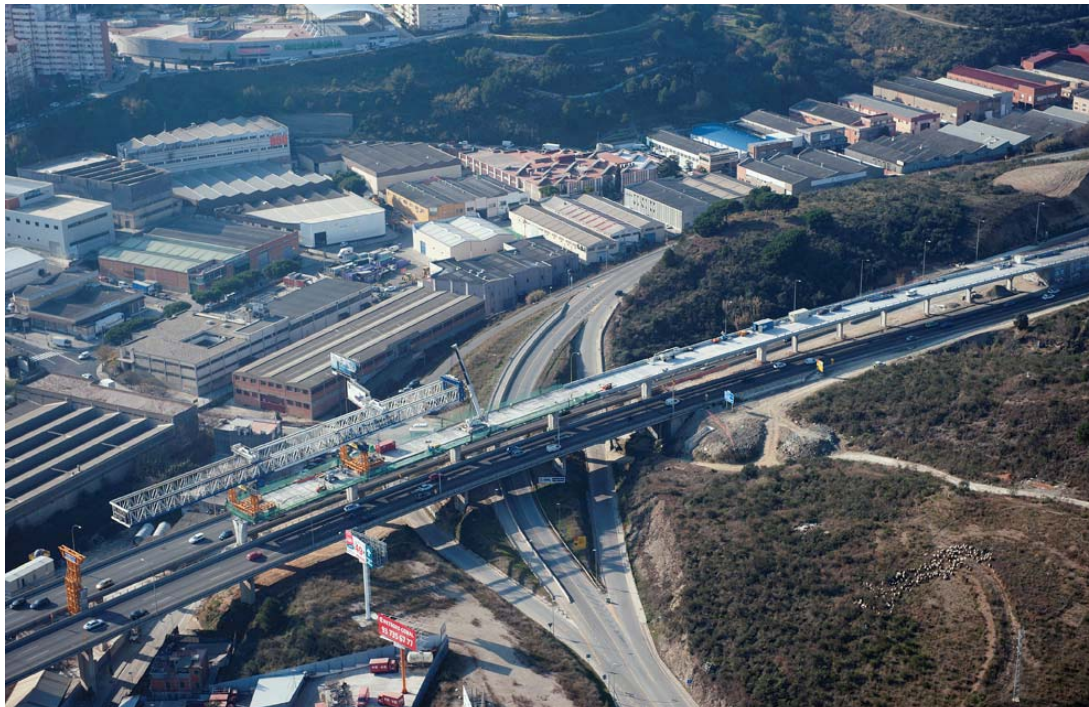
Foto 5: Ejecución de vanos del viaducto principal mediante lanza vigas.
