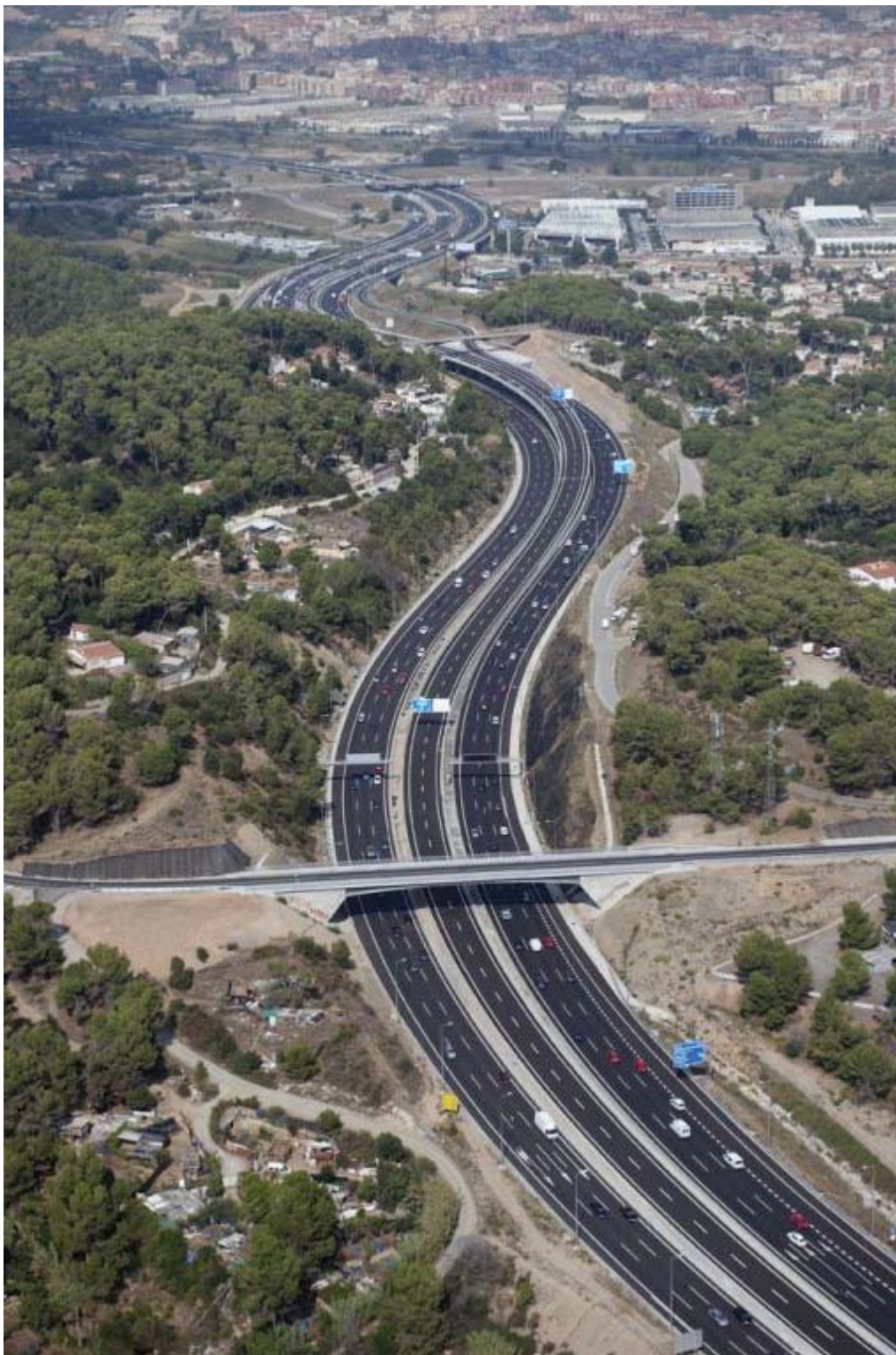
Vista general de la autopista C-58 y el carril bus-VAO en el centro. Vista del nuevo puente de la carretera del cementerio de Collserola construido con motivo de las obras del carril bus-VAO.
