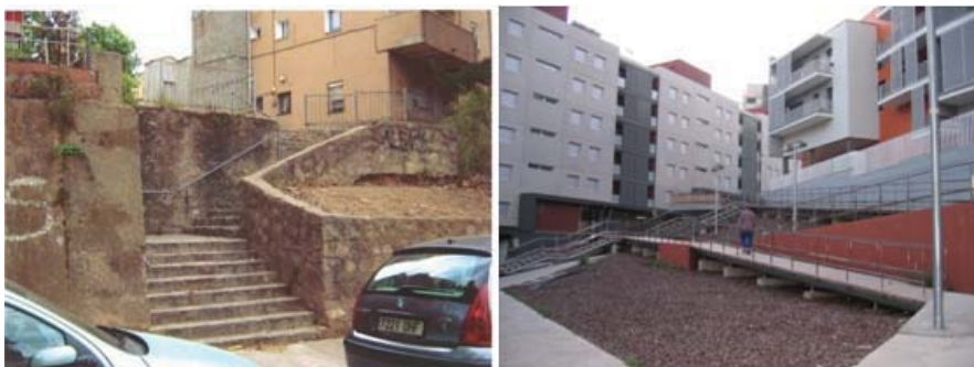
Acceso des de la calle Palamós: Estado inicial y final
