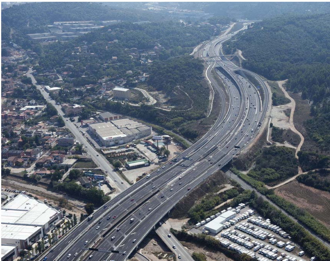
Vista general de la autopista C-58 en la zona de Ripollet-Montcada i Reixac con la pérgola tridente de acceso y salida del carril bus-VAO.
