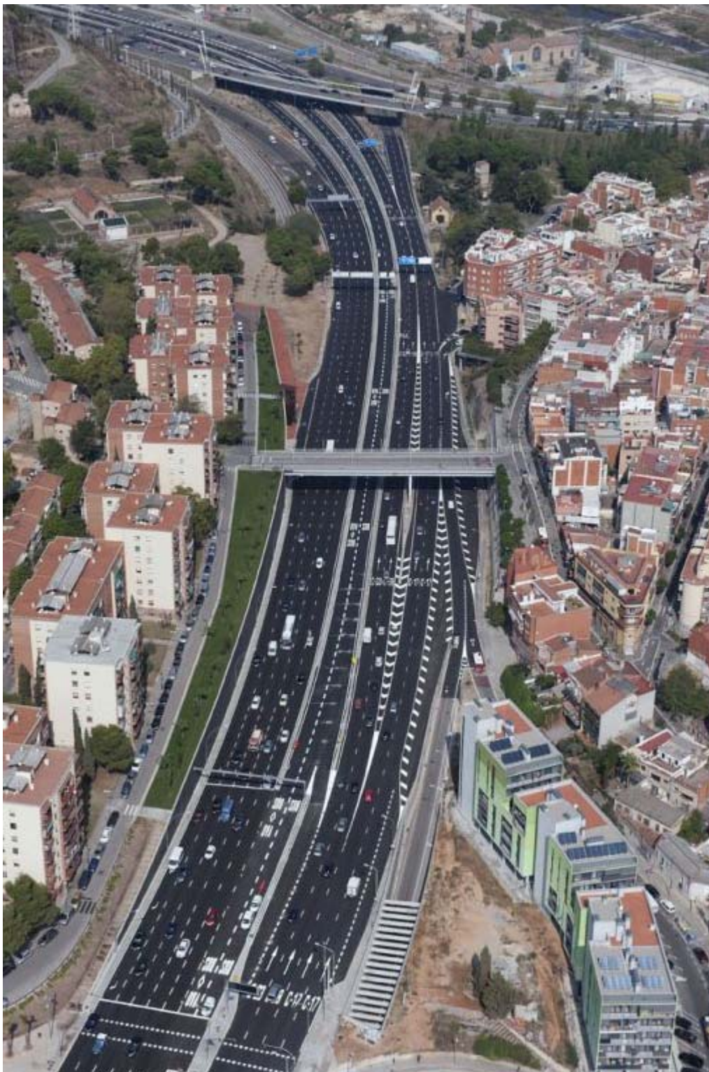
Entrada del carril bus-VAO a la Avenida Meridiana de Barcelona.
